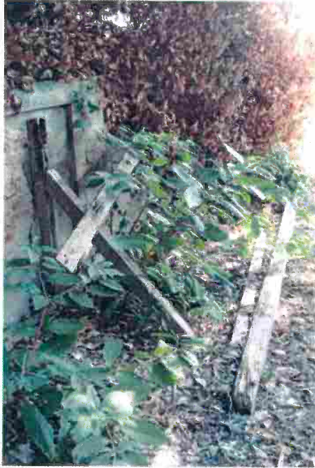
Recinzione lato ingresso sud (tratto già messo in sicurezza mediante l'installazione di puntelli )
