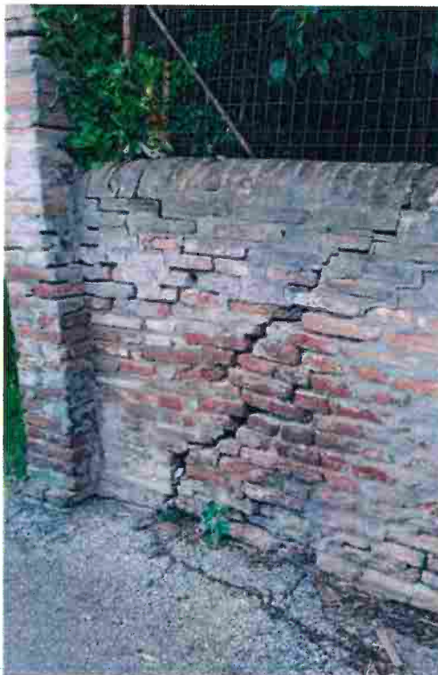
Spigolo recinzione sud-est
