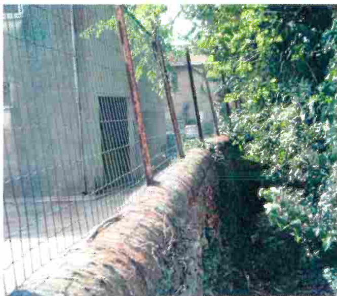
Particolare del muro di recinzione dall'interno- lato est
