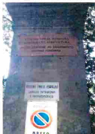
Pilastro di ingresso del cancello
