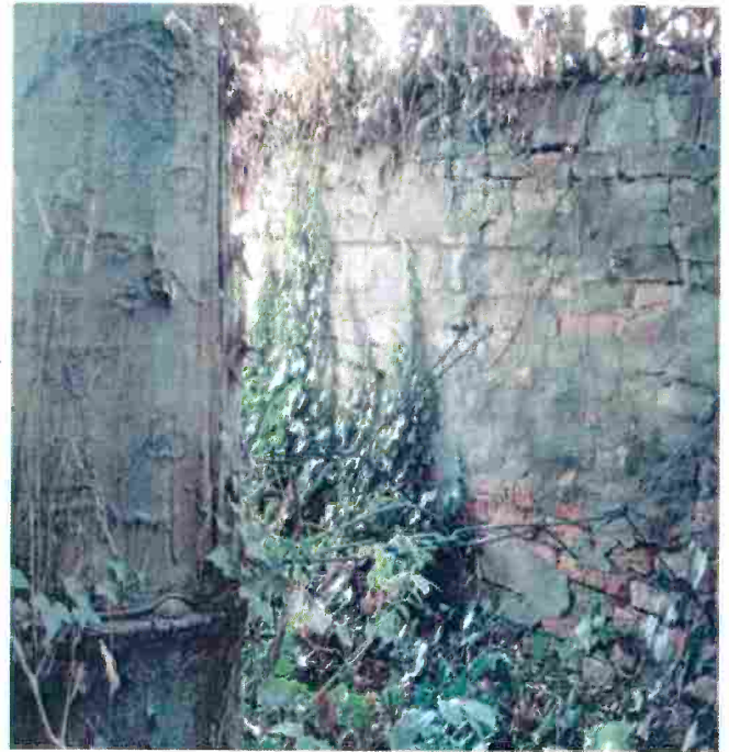
Recinzione lato ingresso sud ( vista interna delle funi )
